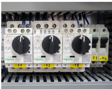
Figur 9: Beskyttelseskredsløb
