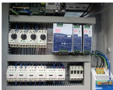
Figur 13: Beskyttelseskredsløb
